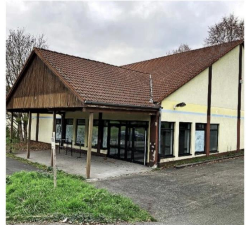
Im Zuge der Eröffnung eines neuen Edeka-Markts im benachbarten Weidach wurde der kleine Edeka in Scheuerfeld vor Jahren geschlossen. Seitdem steht die Immobilie leer. Foto: Christiane Lehmann
